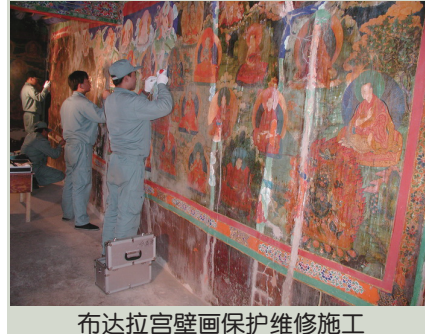
布达拉宫壁画保护维修施工
